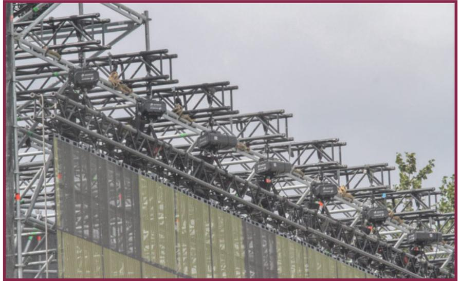
*Nicht nur die Traversen im Bühnenbereich, sondern auch die LED-Wände hängen an Motoren*
